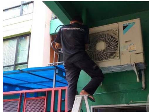
ทำความสะอาดแผ่นกรองอากาศ เครื่องปรับอากาศ
