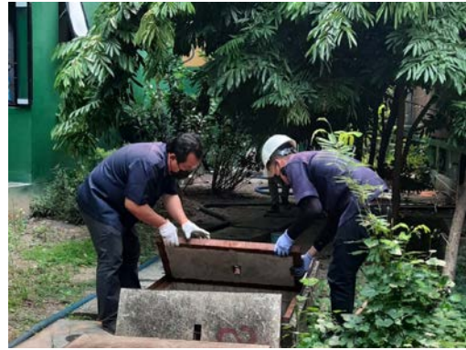
ดูแล/ตรวจสอบบ่อพักน้ำ (Manhole) สุดท้าย ก่อนระบายออกสู่ท่อสาธารณะ
